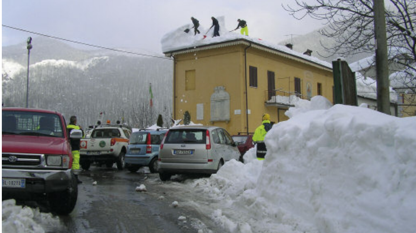
Mondovì: al lavoro sul tetto della casa di riposo.
